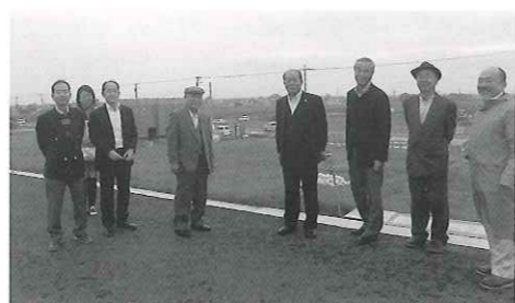
茨城県常総市の堤防決壊現場
